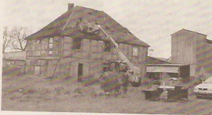
Vor Weihnachten bei Arbeiten am Dach.
